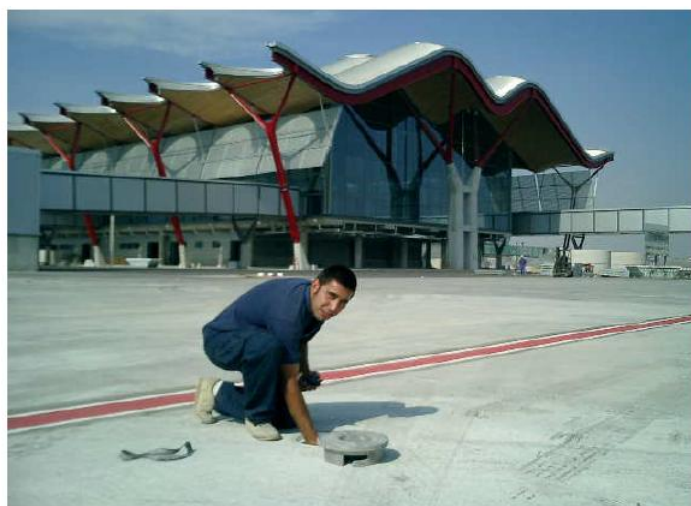
Проверка сенсорного кабеля TT5000 может быть легко выполнена через люки на любом отрезке 20-километровой системы TraceTek, установленной в аэропорту Мадрида в Испании
