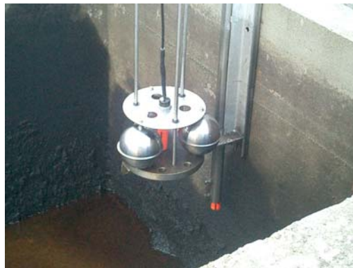
Смешанная плавучая и фиксированная сборка с датчиком TT-FFS в отстойнике/сточном колодце
